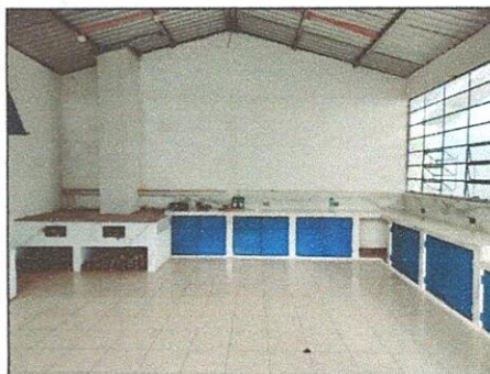
Foto 4: Espacio amplio y adecuado para servir y preparar alimentos.
