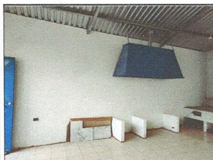
Foto 5: Espacio para estufas industriales y poyetón de concreto, con chimenea y extractor de humo.
