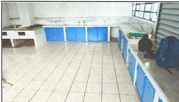
Foto 1: Paredes de block, piso cerámico y cernido de paredes.
