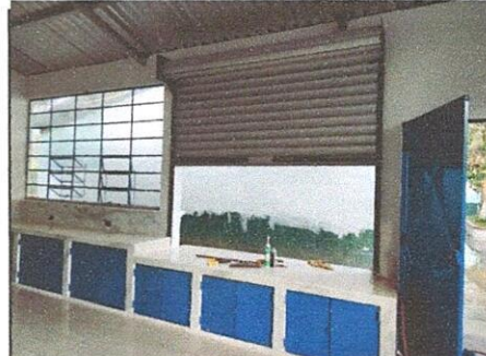
Foto 6: Gabinetes para guardar los alimentos, con puertas de metal.
